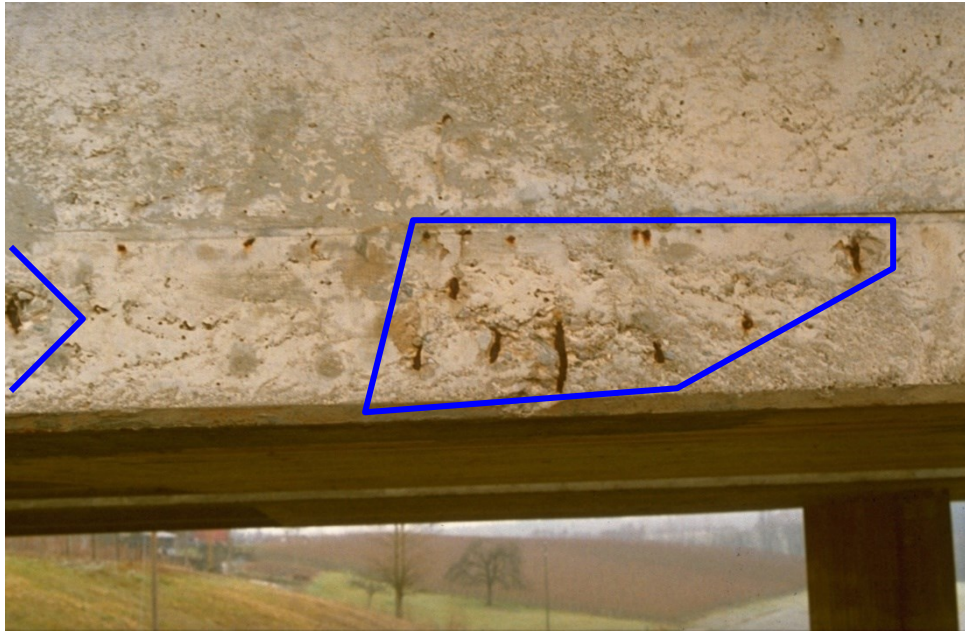
Abb. 4.37 Fortlaufende Segmentierung; Zusammenfassung von Schäden zu einer Schadensgruppe
